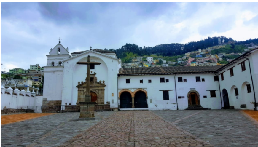
Figura 1. Fachada principal del convento de “San Diego” Quito - Ecuador.
